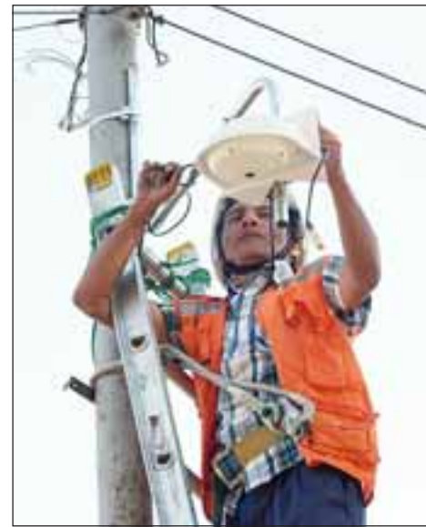
Ya fue instalada la primera cámara de seguridad de alta tecnología en la Plaza de Armas de Putaendo, además de la antena que permitirá que el principal paseo peatonal tenga señal Wifi totalmente gratis.
