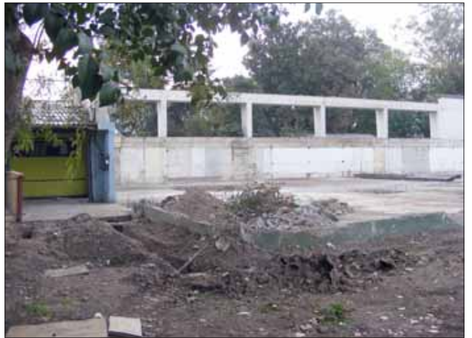
Debido a la aparición de varios detalles en el transcurso de la reconstrucción del terminal, las obras tendrán un atraso de 45 días.
