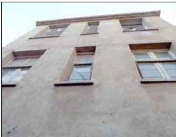
Por esta ventana habrían ingresado el o los delincuentes, debiendo utilizar una escalera para ello.
