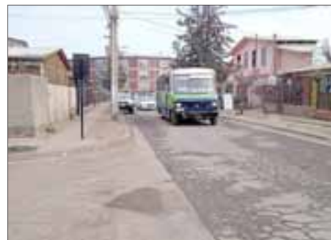
Los trabajos se realizarán por etapas, partiendo esta semana con los pasajes de villa Los Almendros y luego la calle Las Araucarias, en la foto.
