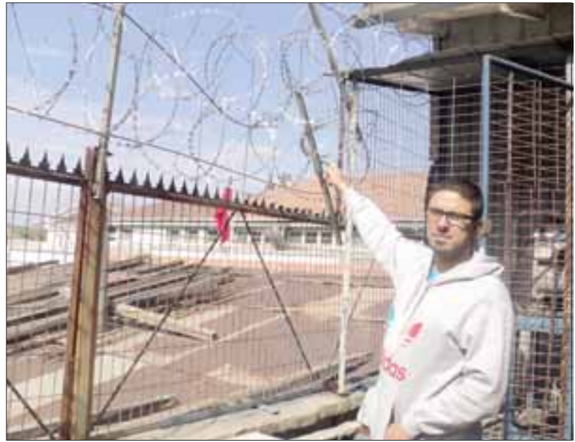
Con estos alambres degolladores se había protegido el local, pero los sujetos ingresaron de todas maneras, al parecer desde el terreno eriazo que se ubica al fondo.
