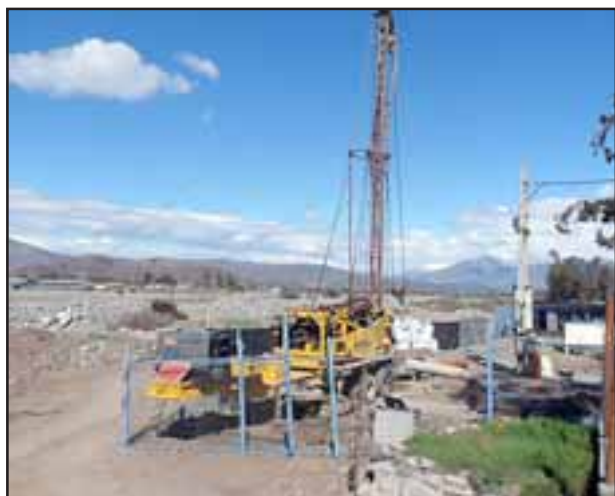
A fines de año o principios del próximo debería estar funcionando el nuevo pozo que está construyendo Esvál en Putaendo.
