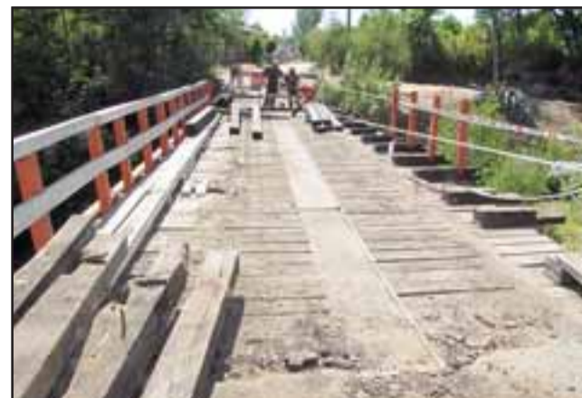
Para el próximo 15 de diciembre debería quedar habilitado el puente 25 de Mayo en el sector de Tierras Blancas.
