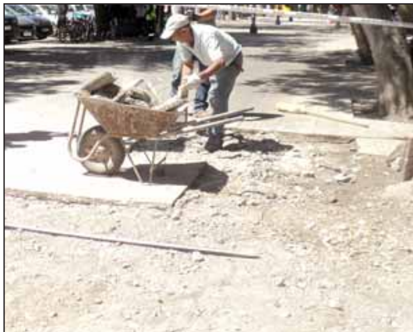
Este jueves deberían culminar los trabajos de reparación de un sector de la Plaza de Armas que se vio afectado por el crecimiento de las raíces de uno de los árboles.
