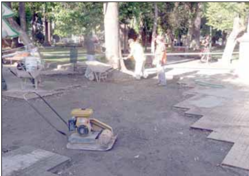
La mañana de ayer el personal trabajaba en la recolocación de baldosas en Coimas con Prat en la Plaza de Armas.
