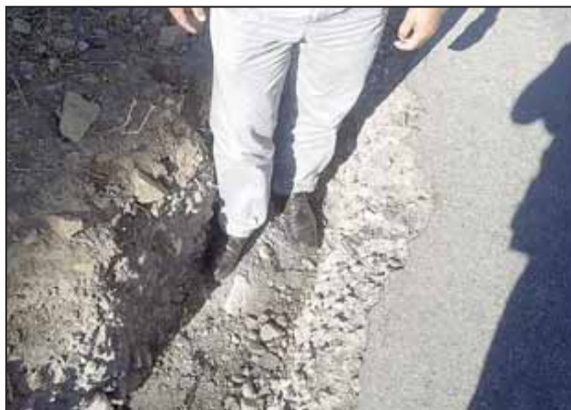
La profundidad de la zanja llega incluso hasta la altura de las rodillas de una persona en algunos lugares.
