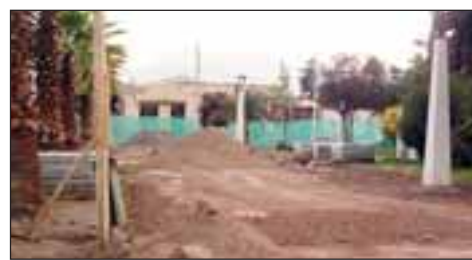
Las obras deben concluir el 15 de enero, pero aún falta todavía la reposición de baldosas.
