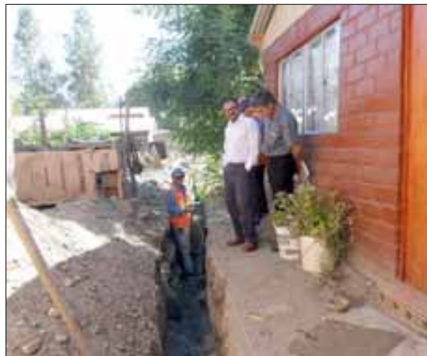
La mañana de este martes comenzaron los trabajos de alcantarillado en el sector de Piguchén.
