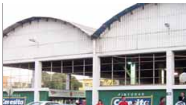
El desmantelamiento del techo en su totalidad debería comenzar esta semana, proceso donde se utilizará un camión pluma.
