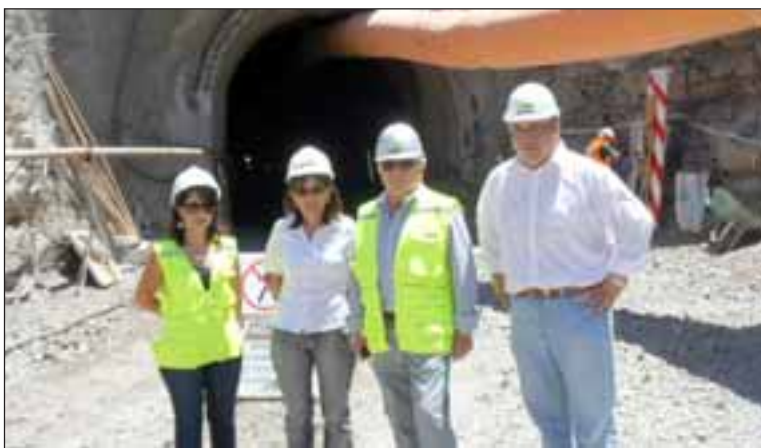
El Ingeniero Solís invitó a la Concejal Arancibia y al Ingeniero Constructor Werner Díaz a ingresar al túnel por donde serán desviadas las aguas del río.
