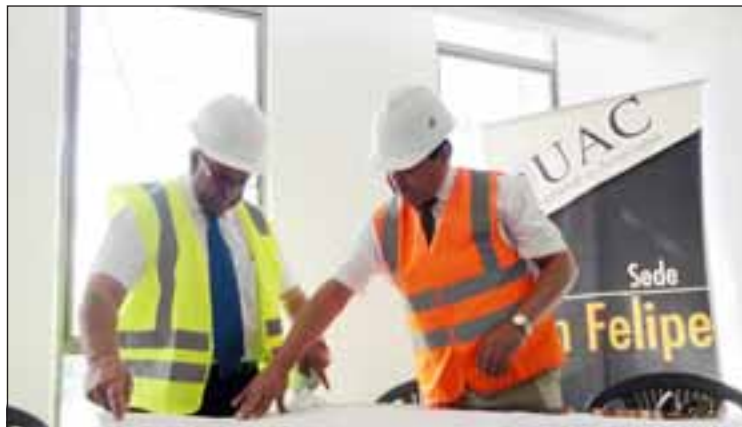
El Director Jorge Escanilla mostró al Alcalde Jaime Amar los planos de esta nueva sede universitaria.
