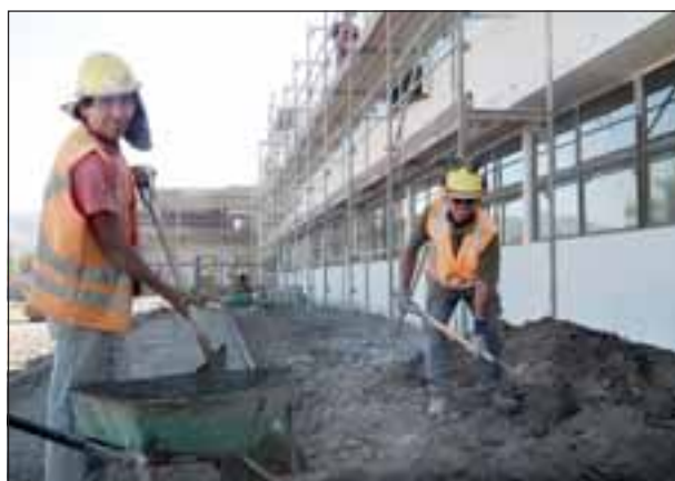
Hugo y Julio son empleados de la constructora que construye esta obra, ellos también están alegres porque gracias a estos proyectos pueden trabajar.
