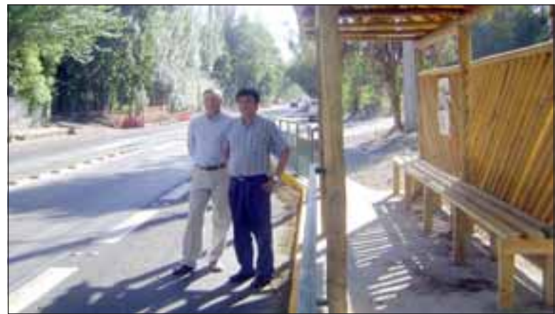
El Seremi de OO.PP., Pedro Sariego, junto al Alcalde Luis Pradenas, visitaron los paraderos de los sectores Palomar y Lo Campo, y los trabajos de pavimentación en Viña Errázuriz.
