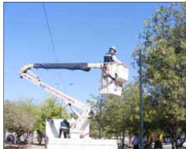
Por estos días se están realizando los trabajos de instalación de focos, mientras que la pavimentación y la siembra del pasto se realizará en los próximos días.
