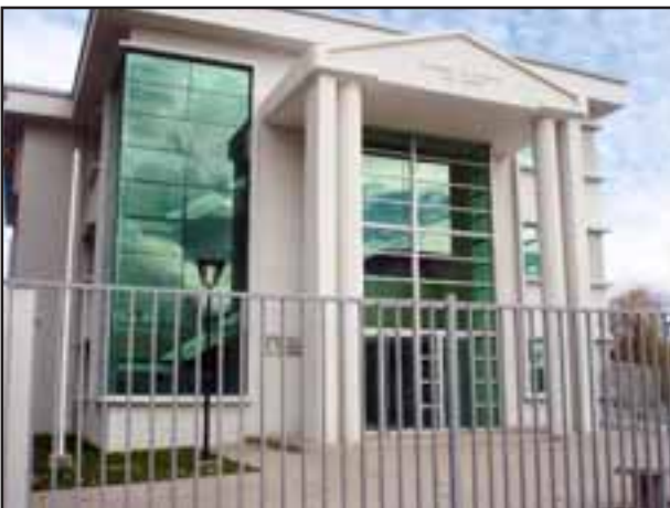
El nuevo edificio de tres pisos y 1.454 metros cuadrados construidos, costó poco más de 2.800 millones de pesos.
