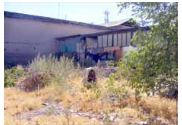
El lugar está abandonado y el pasto seco genera preocupación entre los vecinos ante la posibilidad de un incendio.
