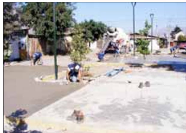
Pavimento liso, escaños y luminaria contempla el proyecto que desde el principio se trabajó con los vecinos de la villa Las Acacias I Etapa.
