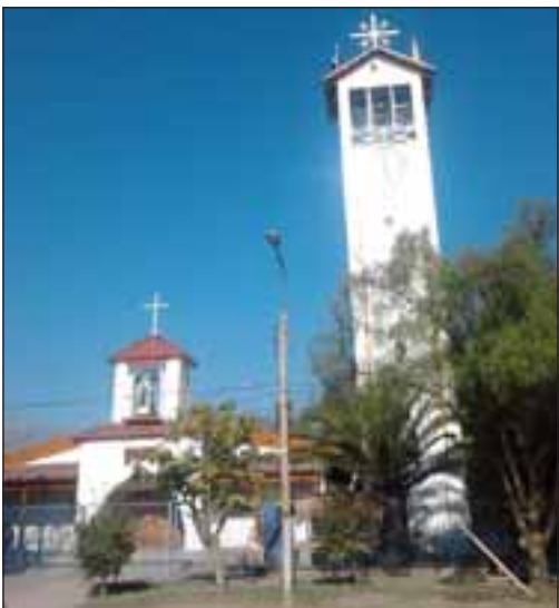
Así luce la fachada de la parroquia de San Esteban actualmente.
