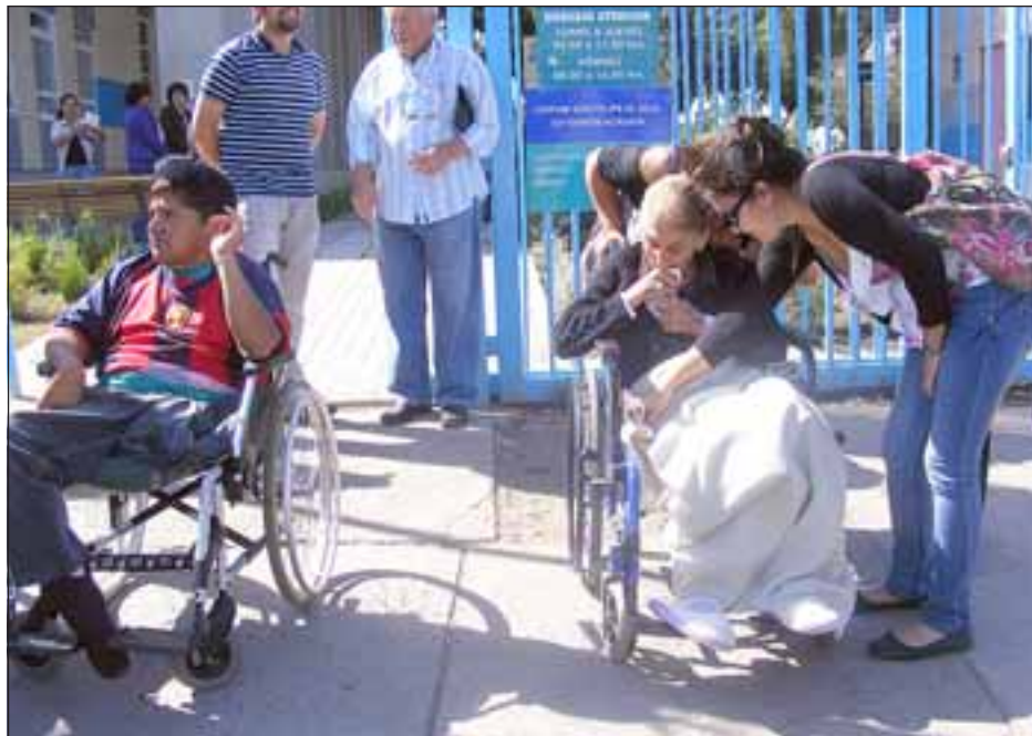
Los minusválidos se ven en apuros para ingresar al edificio, por lo que no pueden venir sin compañía para ser ayudados.
