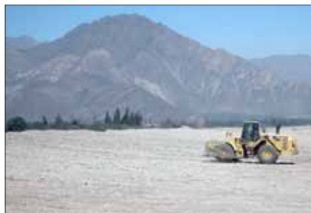
Con este perfilamiento sobre el río, las inundaciones que cada año sufrían los vecinos de El Asiento de Putaendo pasarán a la historia.
