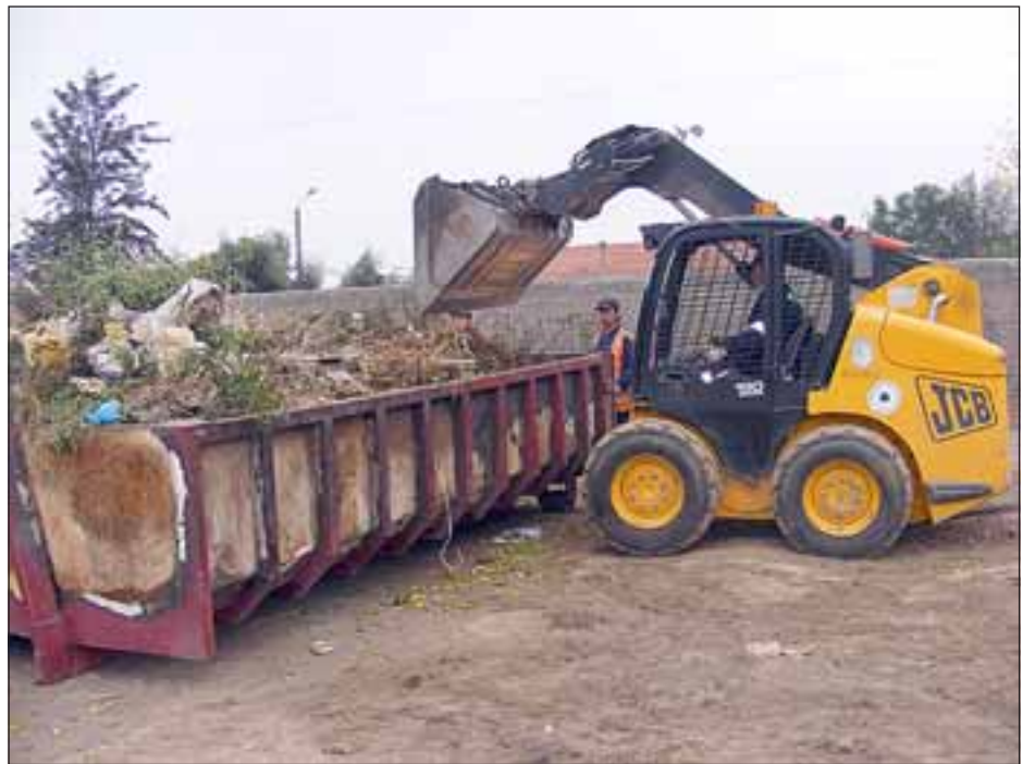
En estos días se está realizando la limpieza por parte de personal municipal, para luego pasar a la construcción de las plazas.
