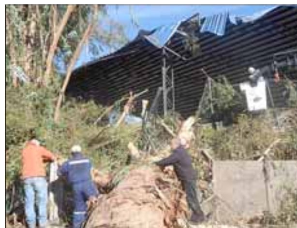
Funcionarios municipales trabajaban para cortar el enorme tronco que cayó sobre la Escuela Renacer de Putaendo.
