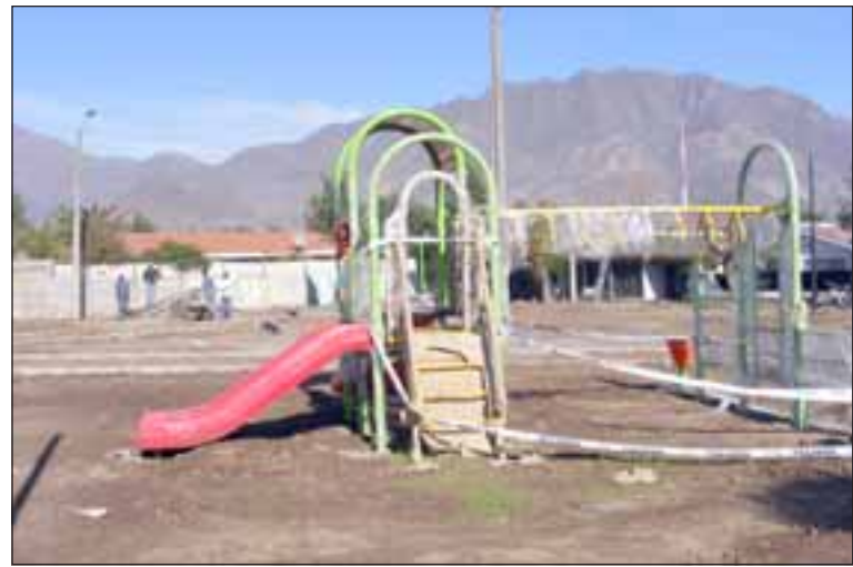
En la plaza ya fue instalado el juego antivandálico, y se espera que una vez terminados los trabajos, los vecinos hagan uso de este espacio.
