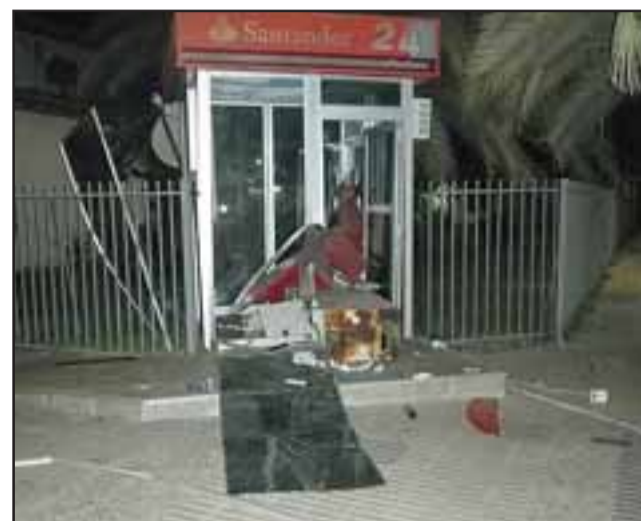
El cajero quedó abandonado metros más allá de donde estaba instalado, ya que los sujetos sólo se llevaron los dispensadores de dinero. Este dispositivo bancario se encontraba a metros de la Municipalidad de Santa María y no contaba con cámaras de seguridad.
