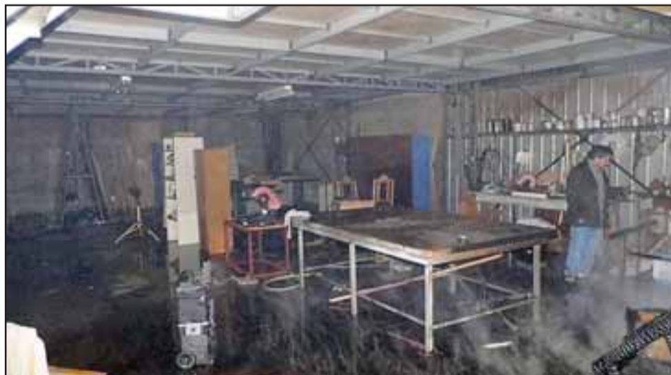
Debido a la gran cantidad de elementos combustibles como madera y solventes, las llamas se propagaron rápidamente por todo el taller alcanzando también un segundo piso.
