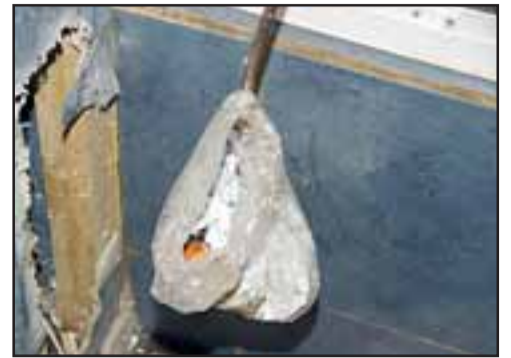
Desde el interior de este desagüe, personal de Carabineros incautó la droga que fue arrojada por la imputada.
