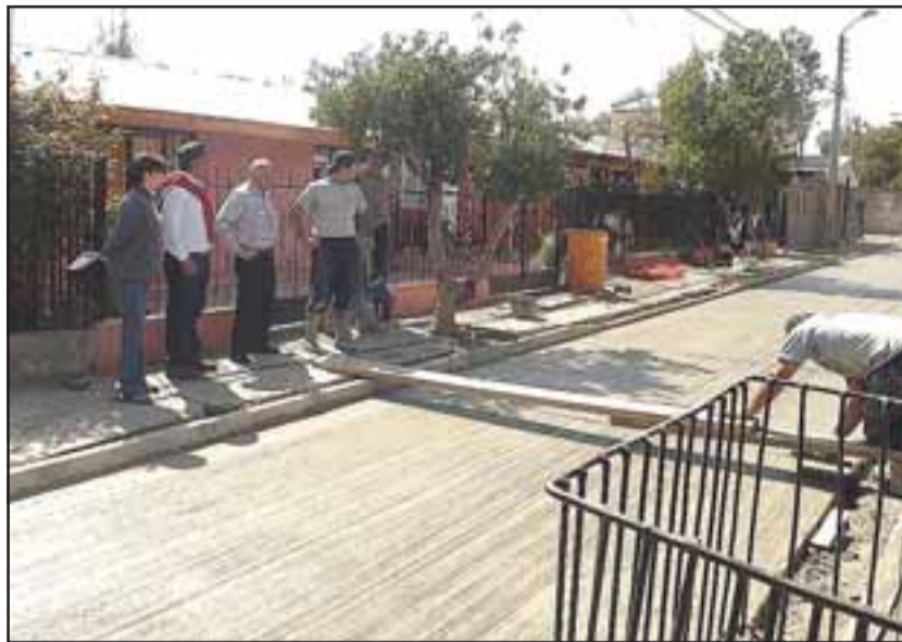
Durante un puerta a puerta, el Alcalde Jaime Amar aprovechó de visitar los trabajos de pavimentación en la población Luis Gajardo Guerrero.
