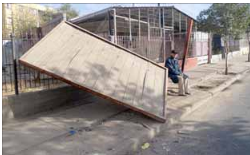
En la parte inferior de la fotografía se aprecian restos de vidrios del vehículo que presuntamente lo impactó.
