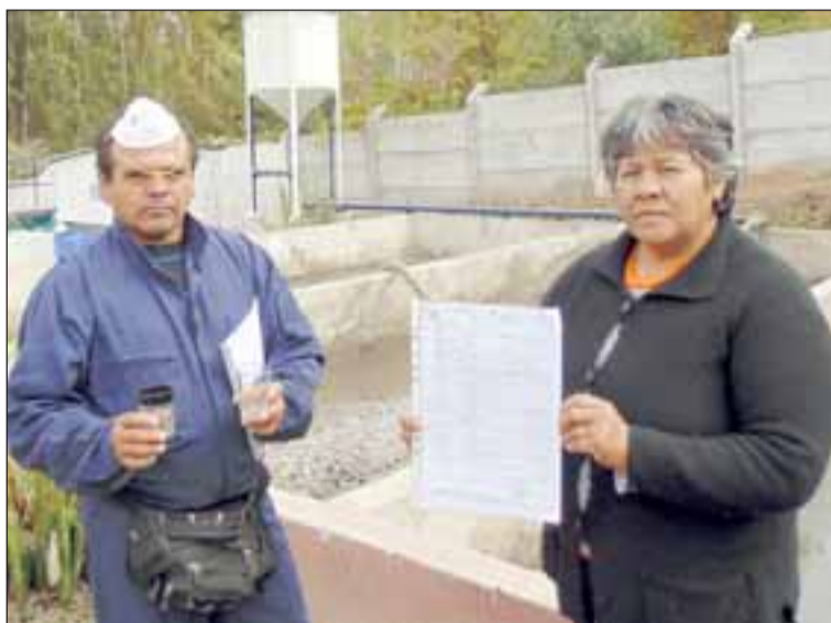
Gloria Alcayaga, Supervisora de la planta de tratamiento, mostró a Diario El Trabajo la última certificación emitida por la Seremi de Salud, misma que fue extendida hace un mes, y que demostraría que todo está en regla. Le acompaña Marcos Báez, operario de la planta.
