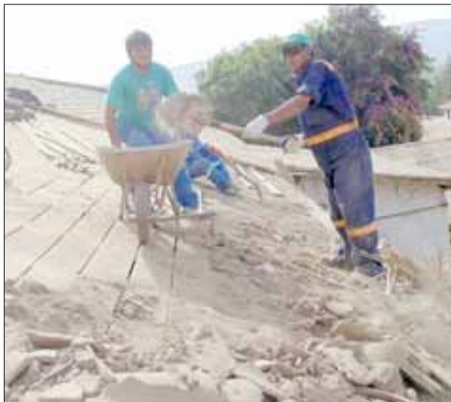
Unas 20 toneladas están siendo removidas de este techo centenario, tanto la madera como la teja inservible, son cambiadas por material nuevo y más fuerte. La inversión es de casi 60 millones de pesos, provenientes en un 50% del Consejo Nacional de la Cultura y la otra mitad de fondos particulares de la misma feligresía.
