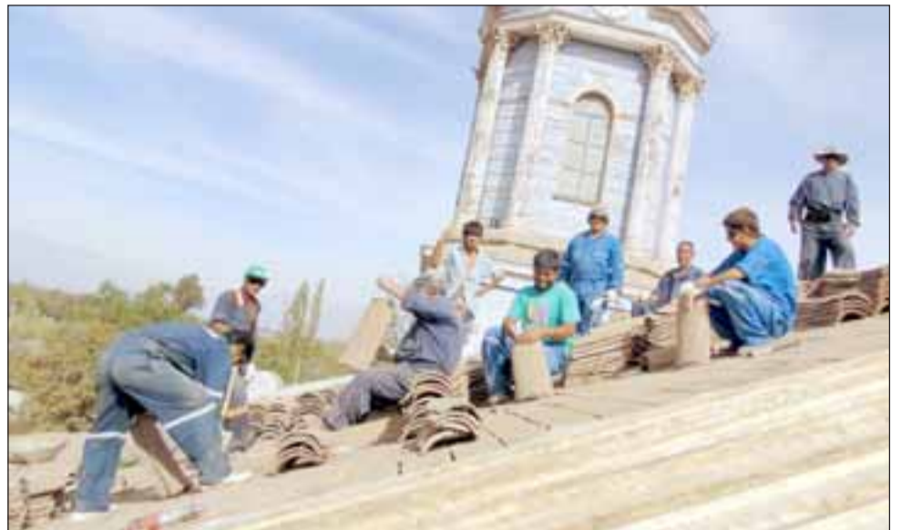
Las cámaras de Diario El Trabajo subieron a lo más alto del edificio, el techo, mismo que será entregado ya reconstruido y reparado el 7 de mayo próximo.
