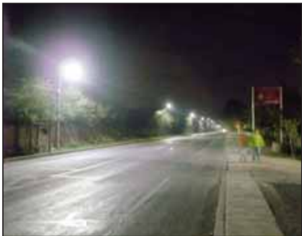
Las nuevas luminarias representan un importante ahorro de energía, al margen de mayor iluminación en sectores apartados y rurales.
