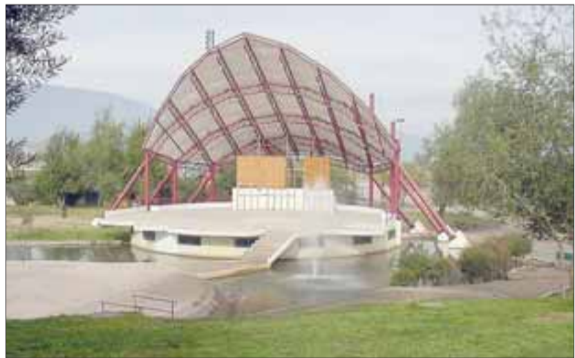
La rehabilitación del anfiteatro es una de las intervenciones que el municipio proyecta realizar.
