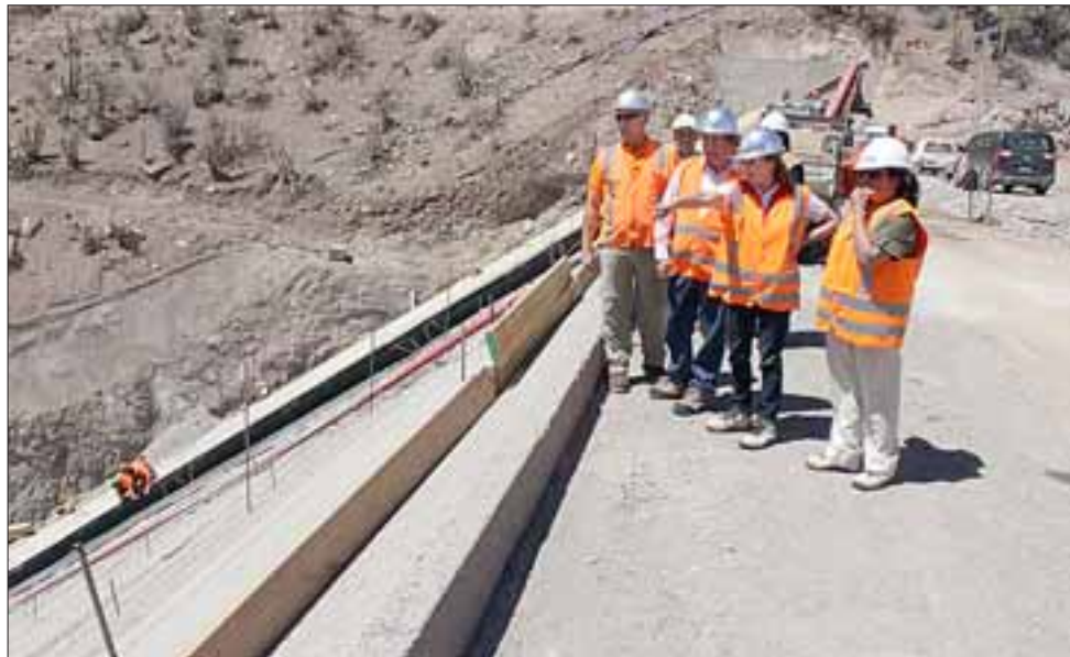
La Gobernadora Patricia Boffa junto al Seremi de OO.PP. y la Directora Regional de la DOH, inspeccionaron el desarrollo de las obras. Este embalse podrá acumular 27 millones de metros cúbicos de agua para riego.
