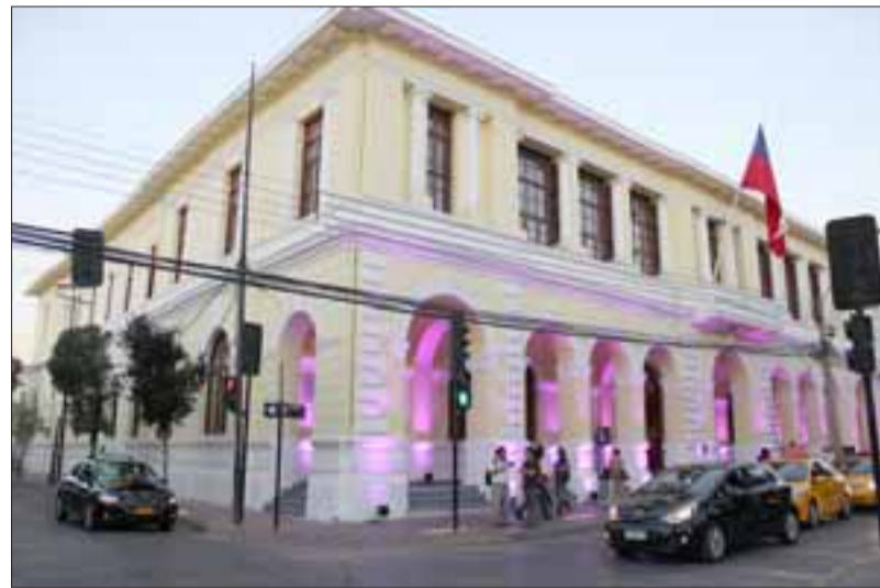
IMPONENTE.- El inmueble posee un estilo arquitectónico neoclásico. Es de volumen rectangular y tiene dos pisos. La cubierta es de fierro galvanizado y los entramados de los entrepisos y techumbre son de madera.
