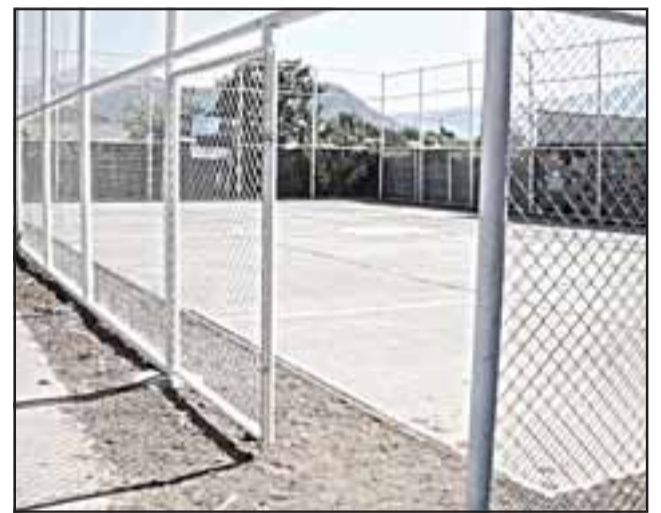
La multicancha de la población 28 de Marzo de Llay Llay cuenta con nuevo cierre perimetral.
