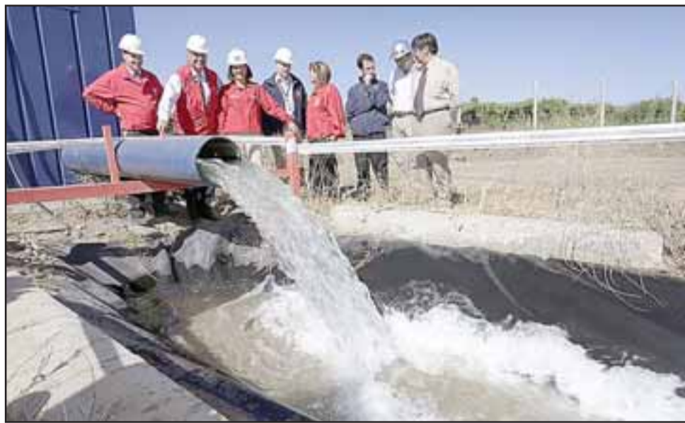
Los 23 pozos construidos por la Dirección de Obras Hidráulicas del MOP, forman parte del «Proyecto Integral de Infraestructura Hídrica para el Aconcagua», los cuales generarán un gran aporte en las zonas deficitarias
