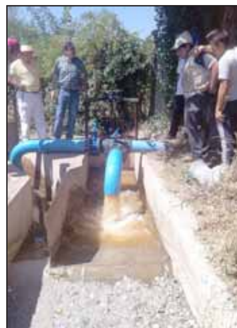
El actual pozo del sector de Las Quillotanas, hoy después de instalar más de 400 metros de tubería especial, permitirá abastecer los canales Rinconada Grande, Canal El Medio y Canal el Cerro, permitiendo resolver problema de riego a más de 300 agricultores del sector.
