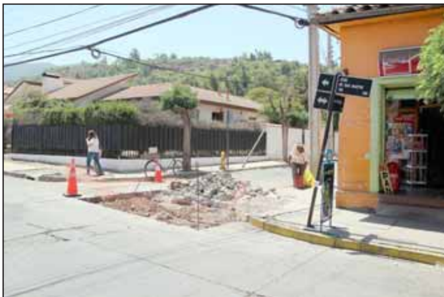
Entre las 15:00 horas y las 23:30 horas del próximo jueves, se deberá suspender el suministro de agua potable en forma transitoria en todo el centro de la comuna, Granallas, Calle Brasil y Rinconada de Silva, ya que durante este horario se realizará la conexión final de la matriz de agua potable.
