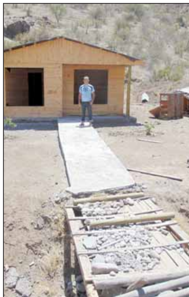
Esta casa prefabricada quedó a medio instalarse, pues se agotaron los recursos y sólo las autoridades o usted, amigo lector, podrán marcar la diferencia.
