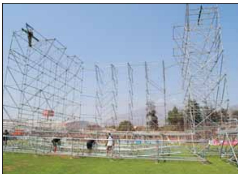
A toda máquina se trabaja en el estadio Municipal, desde el domingo pasado, día en que llegó un primer cargamento con el escenario, que por sus dimensiones comenzó a armarse de inmediato y ya el lunes era posible ver la imponente estructura.
