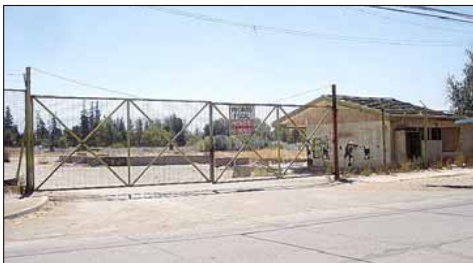
Al margen de instalaciones para Bomberos y Defensa Civil, el terreno de la ex Aduana sería utilizado para construir un helipuerto.
