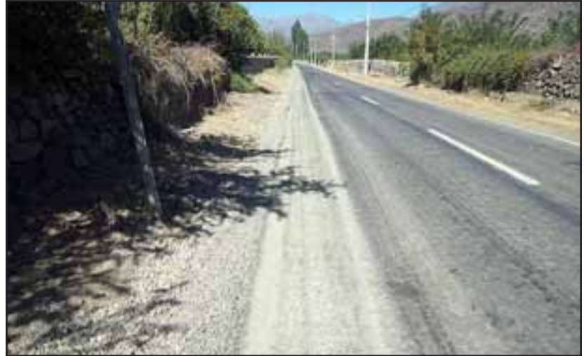
Desde el kilómetro 10.650 hasta el 13.000 se realizó un trabajo de bacheo profundo con tratamiento superficial asfáltico con un espesor de entre 12 y 15 centímetros.
