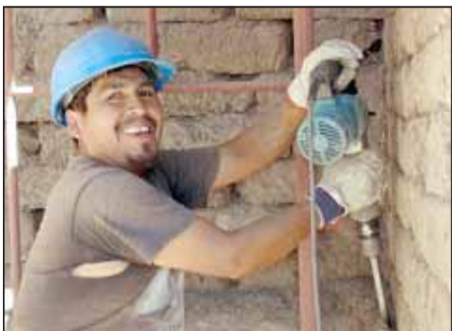
Juan Carlos Huenumil, obrero que debe limpiar y reparar cada uno de los adobes del santuario, como él, casi 30 trabajadores laboran con ahínco para sacar a tiempo la obra.
