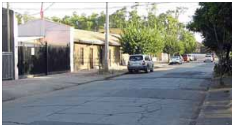
Los trabajos en Avenida Independencia partirán hoy lunes y se extenderán por cuatro meses, periodo en el cual esta importante arteria permanecerá cerrada.
