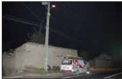
En este poste se generó la explosión al hacer la lechuza contacto con los peligrosos cables.
