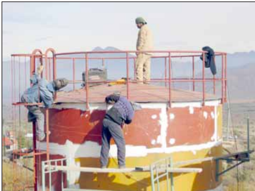
La parte de soldadura ya está en su fase final y los vecinos de Santa Filomena y alrededores pronto verán solucionados parcialmente sus problemas de agua potable.
