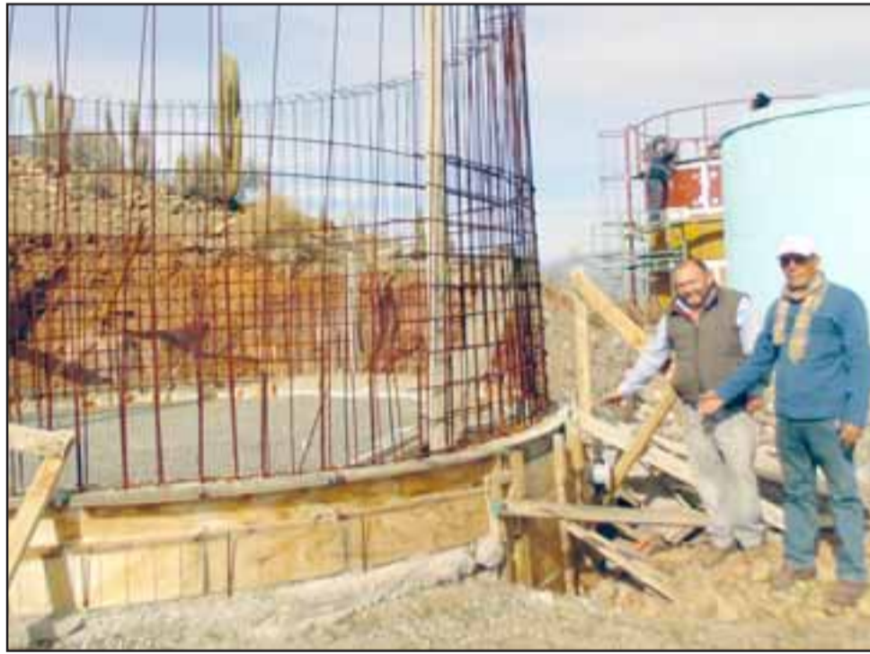
Este es uno de los pozos abandonados que se dejó en el olvido hace tres años, cuando la empresa encargada quebró y todo quedó paralizado.
