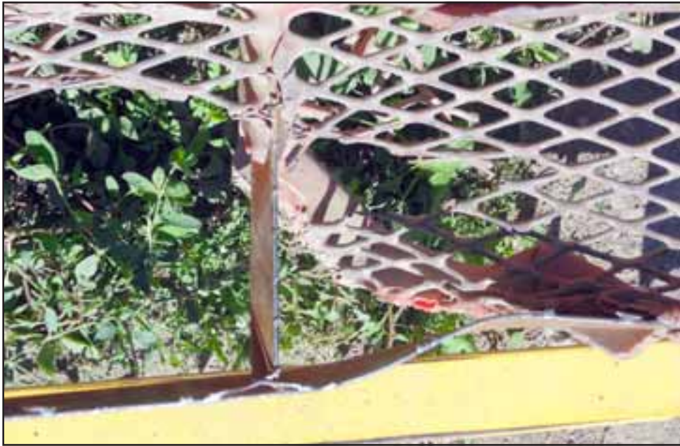
Así lucen las escalas metálicas en los juegos infantiles, desde esta misma una niña cayó y se hirió la cadera.
