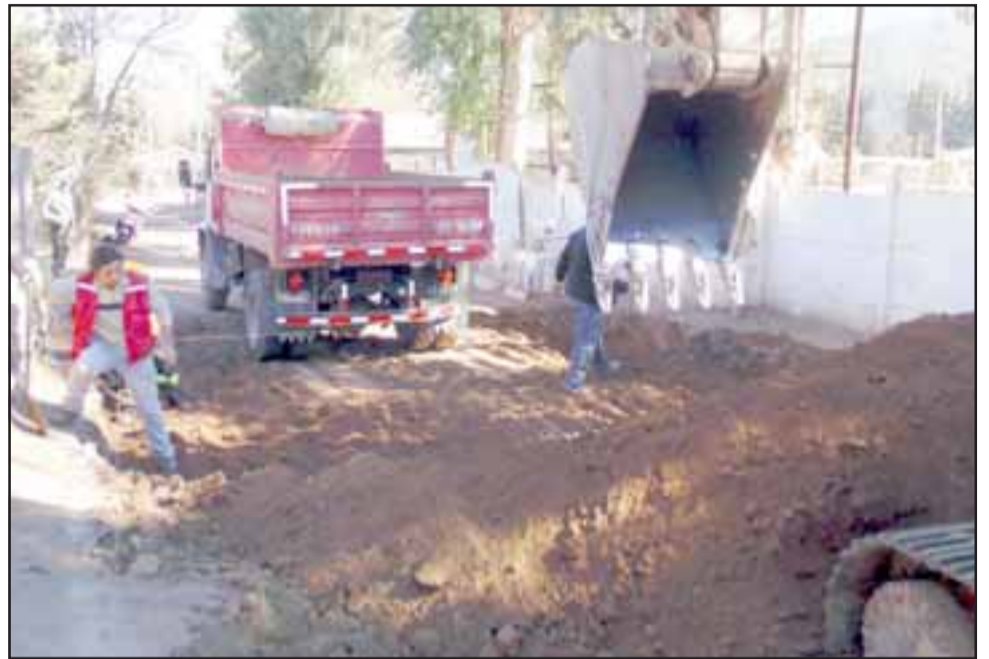
Ya los trabajos se están ejecutando en El Algarrobal y los vecinos están más que contentos, pues son muchos años de estar respirando el polvo de las calles de tierra.
