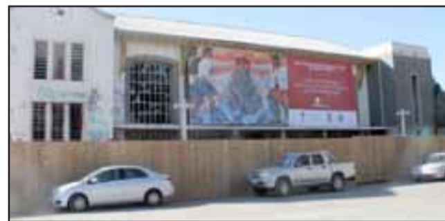
Se pretende rescatar la ex estación de ferrocarriles, que ha permanecido abandonada por más de 20 años, y darle un nuevo uso destinado a la cultura.
