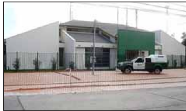
Carabineros del Retén de San Esteban desde el jueves 6 del presente mes ya está atendiendo a la comunidad en el flamante cuartel construido para la tenencia, cuya dirección es Avenida Alessandri N° 206.
