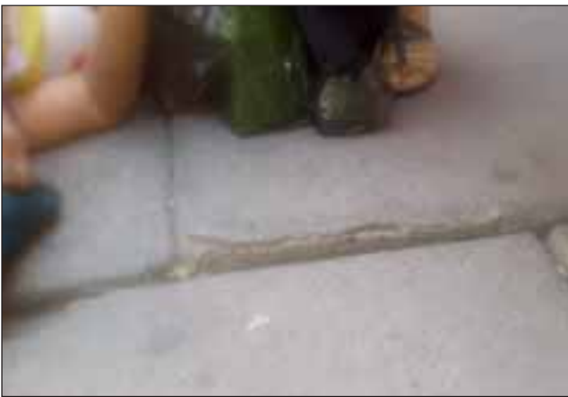
Este es uno de los bloques desacomodados tan regularmente peligrosos en las aceras de nuestra ciudad. Este mismo casi le cuesta la vida a una persona durante la mañana de este martes.
