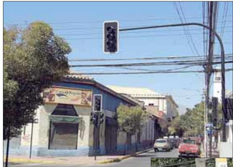
Los semáforos de San Felipe también quedaron fuera de servicio, quedando a criterio de los conductores la responsabilidad de marcar el tránsito en carretera.
